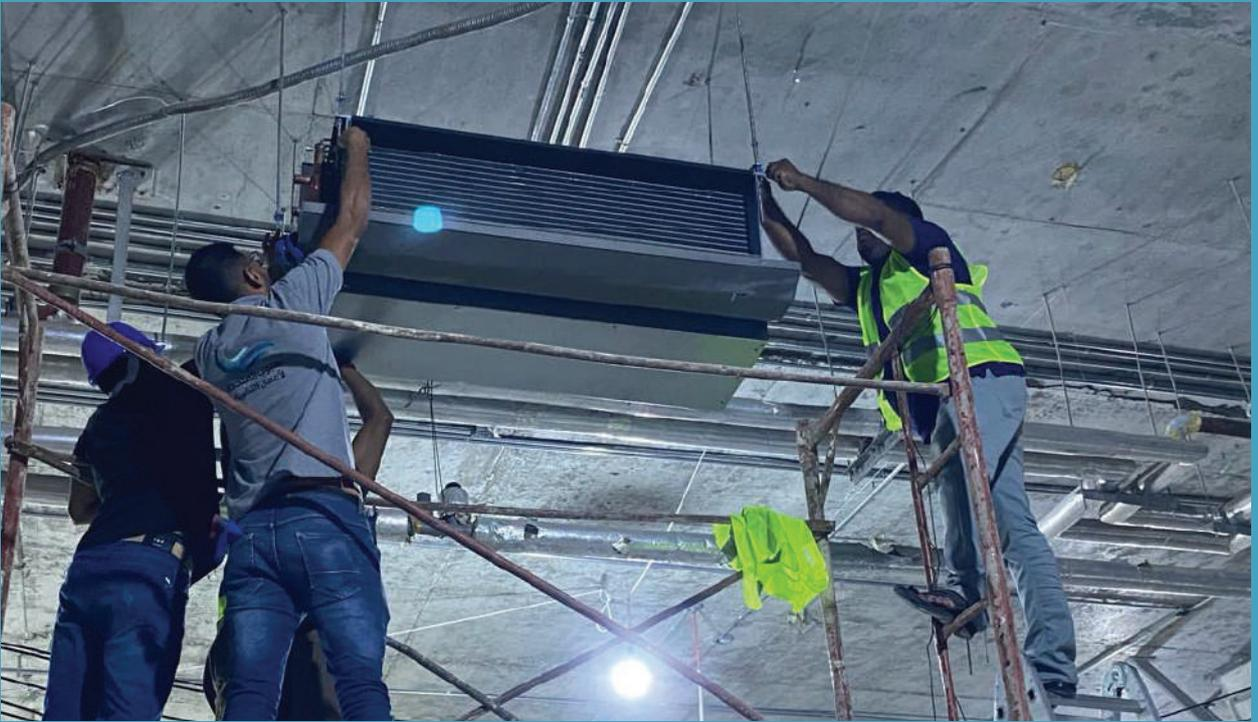
تنفيذ أعمال تكييف تشيلر في برج الساعة بمكة المكرمة مع أعمال تمديد وعزل مجاري الماء المغذية لوحدات التكييف مع تركيب وحدات بقدرة ٢٥ طن تبريدي مع توريد وتركيب مجاري الهواء المعزولة بالقماش ودهنها باللون الأزرق .
